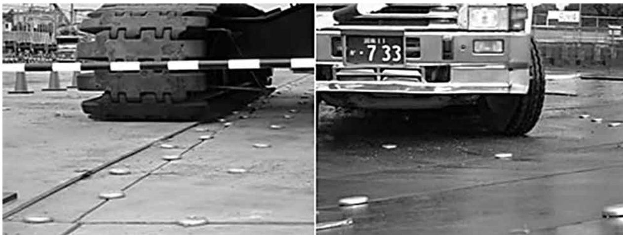
リンクプレートによる施工例 / 鉄板の堅結状況
