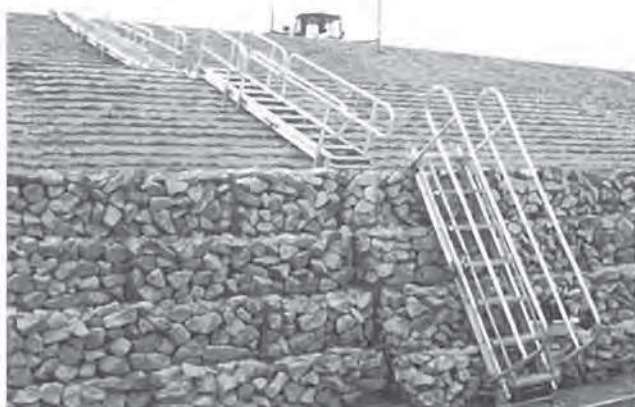
護岸工事用昇降階段として…
