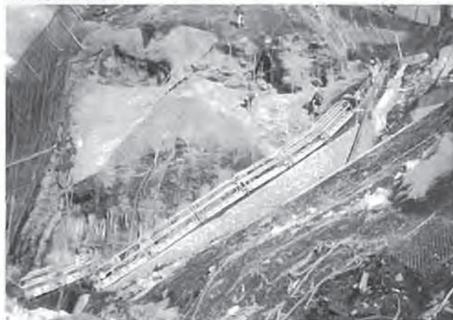
法面用通路として…
