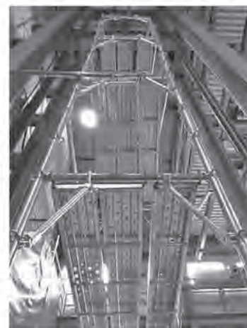
支柱強化の荷重試験
