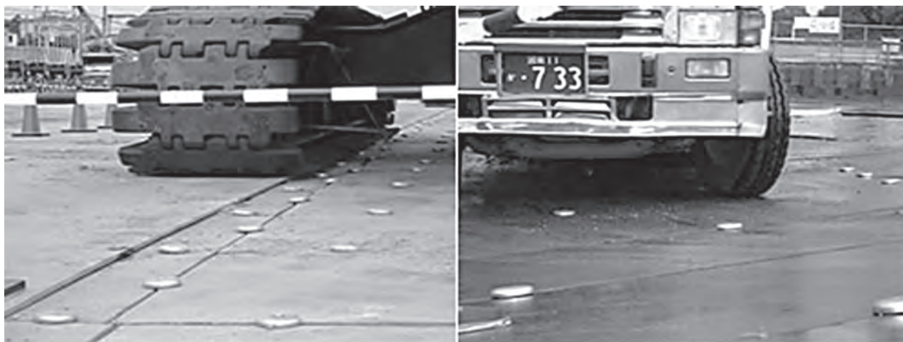
リンクプレートによる施工例 / 鉄板の堅結状況
