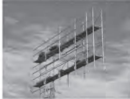
アルバトロスの作業床は1層分の支柱長さの中間部に位置し、また上層の手すりは手すり先行工法で取り付けることができます。このため部材取付作業は地上と高さ約1mの作業床上から全てを行うことが可能です。
