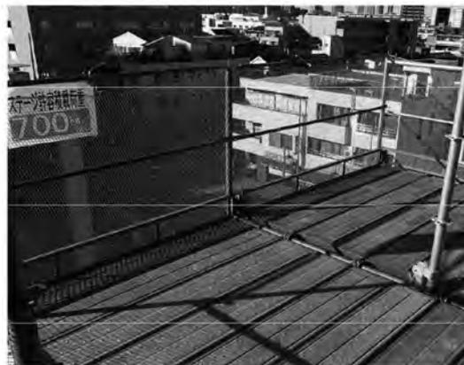
アルパトロスはRC工事の必需品、ユニット式の専用荷取り・荷出しステージも品揃え。型枠材料の盛替え、仕上げ材の搬入も簡単です。枠組足場用と同様、もちろんクレーンを使って丸ごと上層階へ転用可能です。最大3スパンまで設置可能です。
