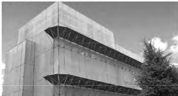
アルパトロスは金具のみ専用金具に替えるだけで枠組足場用のアルミ朝顔が使用可能。
