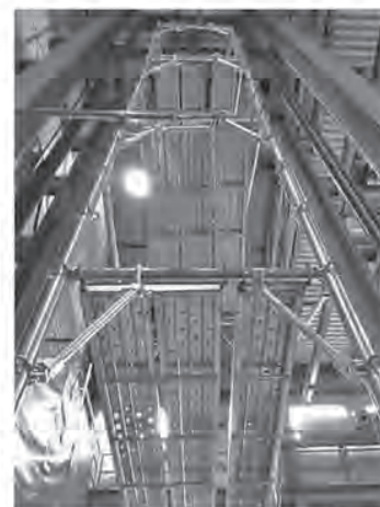
支柱強化の荷重試験
