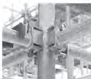
中間部分・縦横のつなぎ材。
