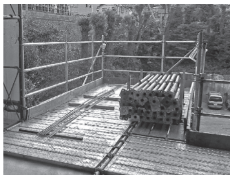
梁枠併用で広い開口確保
