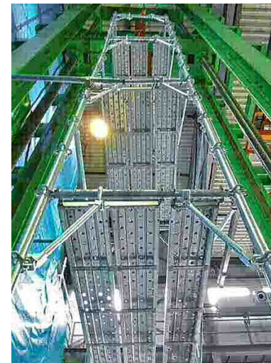
支柱強化の荷重試験
