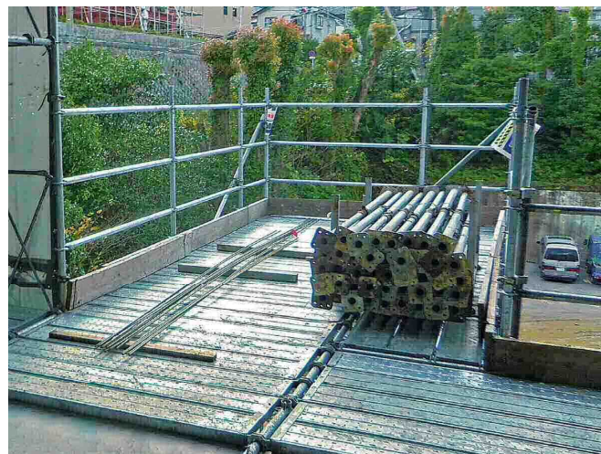
梁枠併用で広い開口確保
