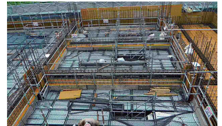
支保工のステージ 作業床は段差なく手すり付き昇降設備も容易 在来型枠支保工と組合せて設置し、存置期間後は設備工事用のステージとしても無駄なく利用可能
