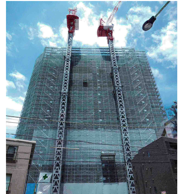
高さ80メートル超のタワーマンション 強化方づえ使用 B2階からの立ち上がりの足場部分は最高高さ約90メートル
