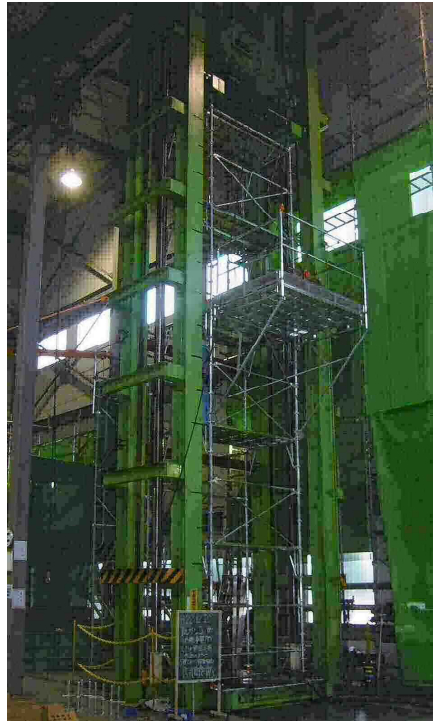
偏芯荷重に鉛直荷重加えた過酷な実大実験 仮設工業会東京試験所
