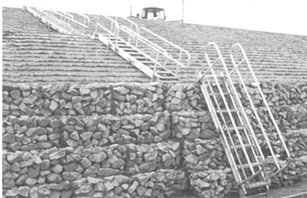
護岸工事中用昇降階段として…
